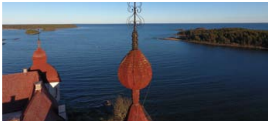
Även spiran, spåntaken och kyrkfönstren åtgärdas.
